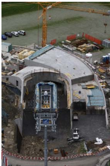
Bau Portal: runde Wände
