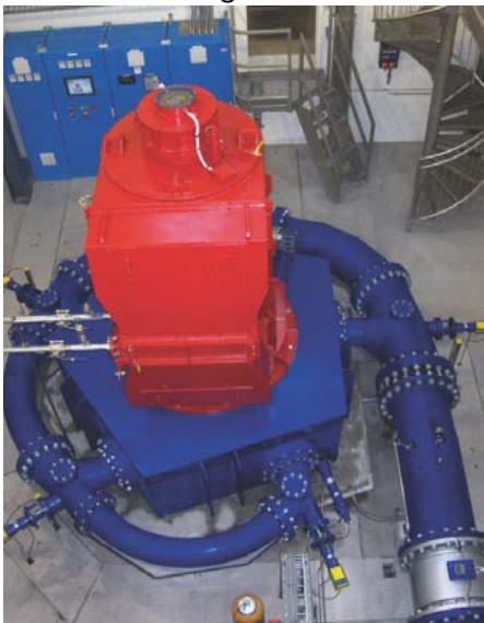
Rabiosa-Maschine mit einer Leistung von knapp 700 kW
