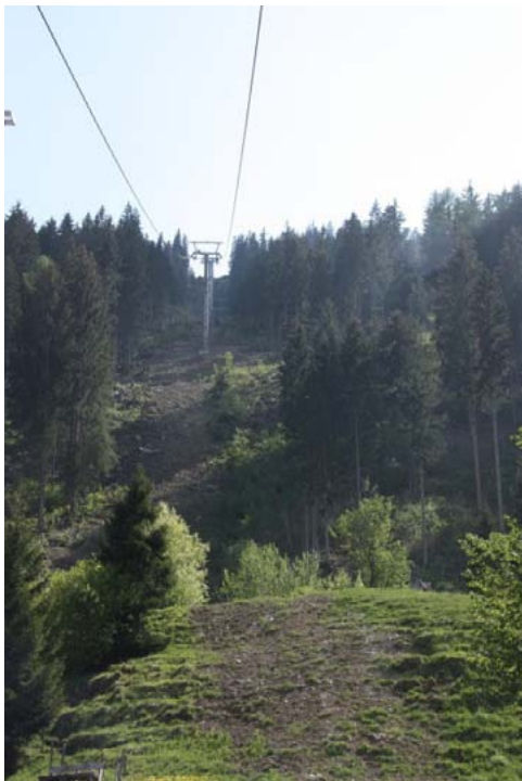
In steilem Gelände wurde die Mittelspannungsleitung eingezogen.
